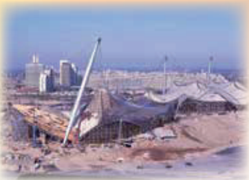
Das Olympiagelände im Bau: Im Zentrum standen die markanten Dächer für die Sportstätten.
