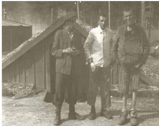
Drei Häftlinge nach der Befreiung in besserer Bekleidung vor einer der Erdhütten.
