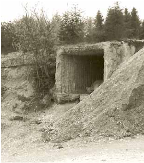
Die Zugänge zu einer der geplanten unterirdischen Produktionshallen in Landsberg/Kaufering; deren Länge betrug 240 Meter, die Breite 80 Meter und die Höhe 30 Meter, heute beseitigt und verfüllt.
