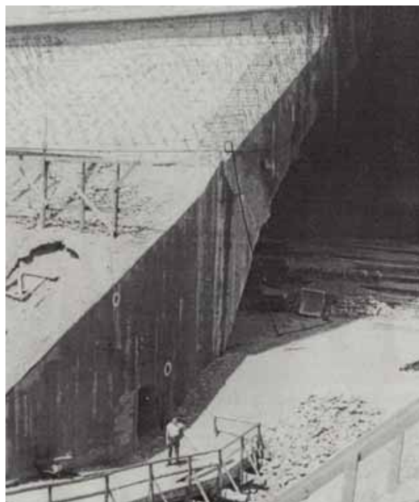
Eines der Seitenfundamente für den Rüstungsbunker.
