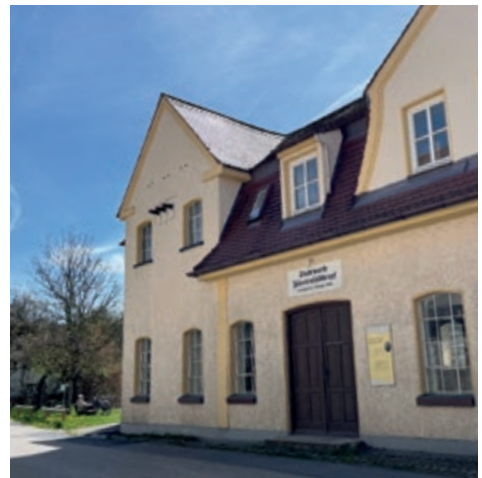
Abb. 26: Bayerns zweitältestes Laufwasserkraftwerk an der Amper in Schöngesing
