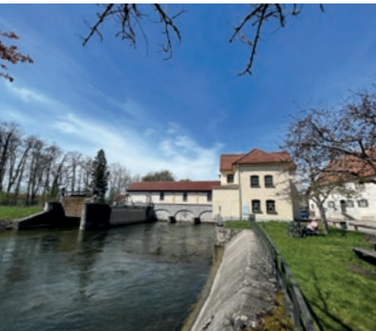
Abb. 25: Blick auf Bayerns zweitältestes Laufwasserkraftwerk an der Amper in Schöngesing
