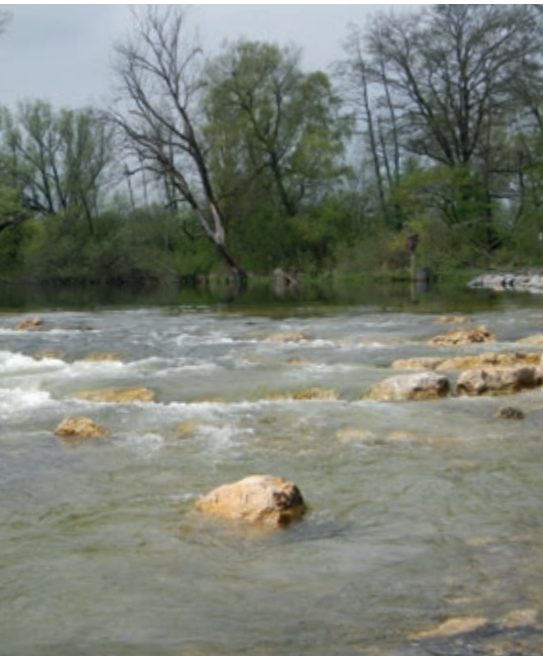
Abb. 6: Die 2013 gebaute Sohlrampe bei Grafrath erhöht den Wasserspiegel der Amper und trägt zur Wiedervernässung des Ampermooses bei.
